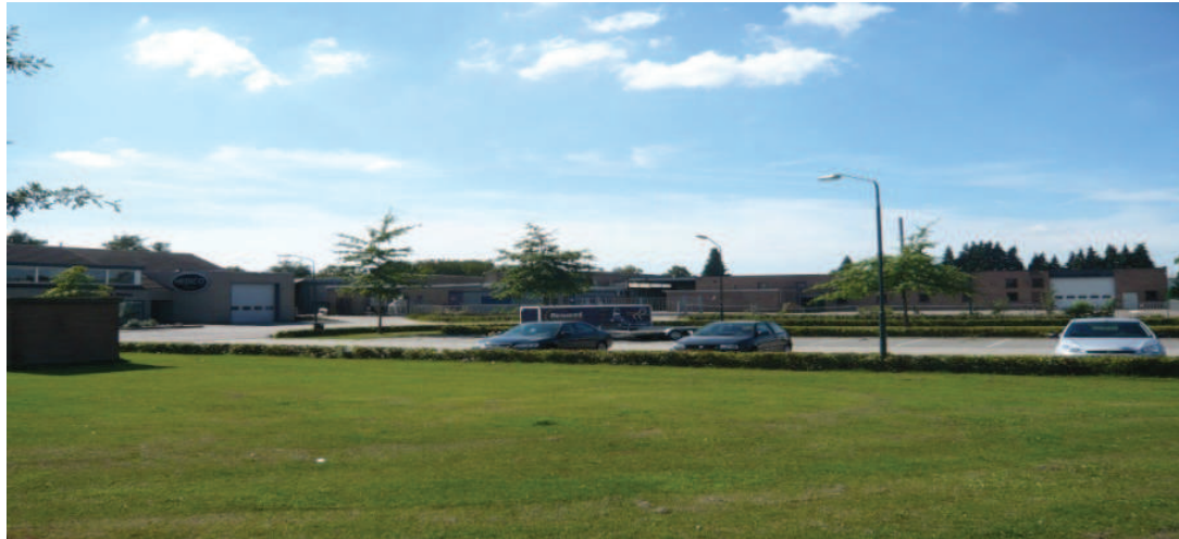
Overzicht bestaande bebouwing plangebied zijde Lange Voren
